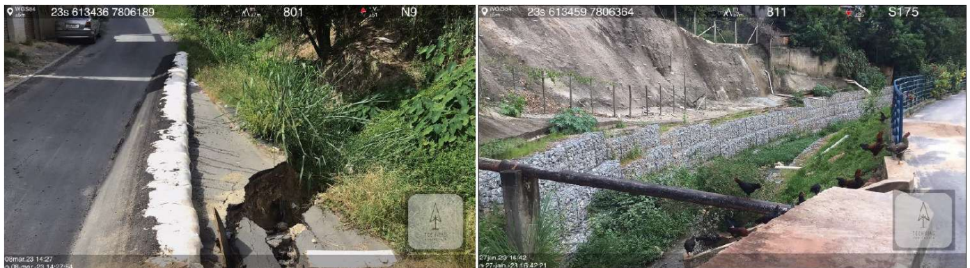
Figura 10 Erosão na área de estudo (foto 801) e estruturas de contenção ao longo do córrego do Açudinho (foto 811) Fonte: Ticket 31.00435860/2025-57
